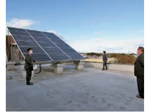
町立公民館の太陽光発電設備
