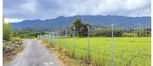
音や臭いでは害獣への忌避効果が薄かったため、柵での侵入防止を図る
