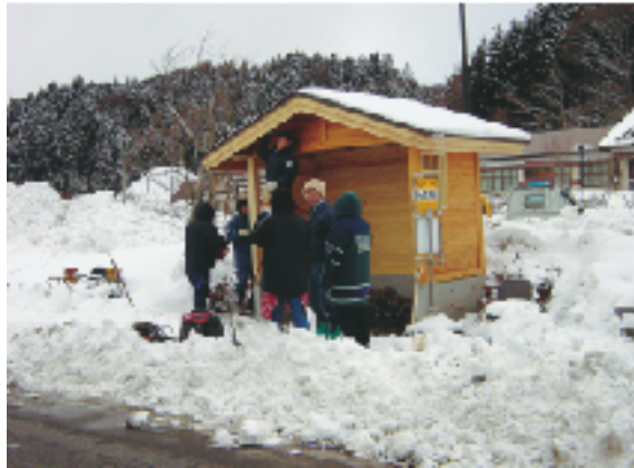
地域で利用するバス待合所の建設
