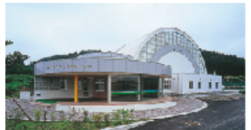
倉石スポーツセンター
