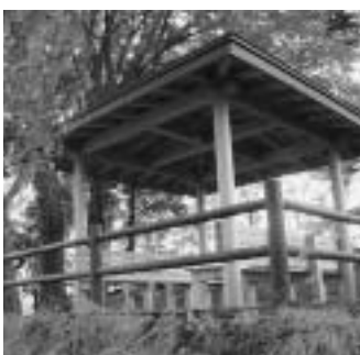
新たに設置された安全柵
