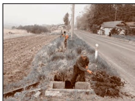
水路の泥上げ
