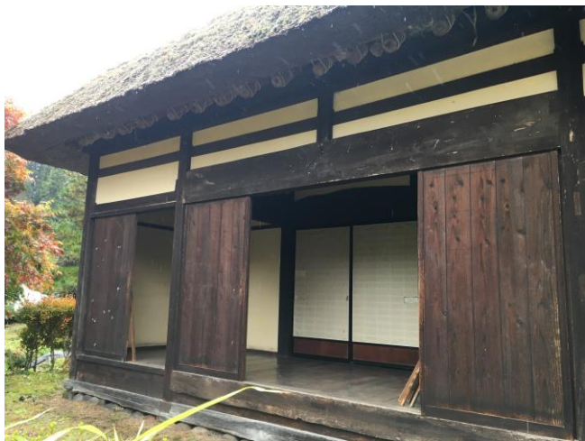
広い縁側でのんびりできます。
