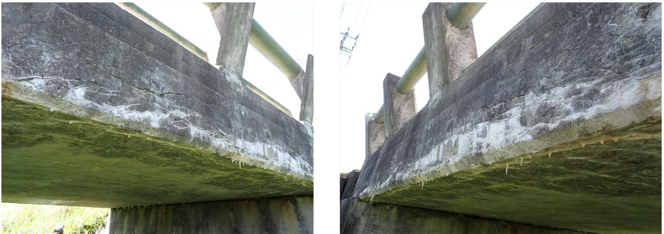
図3-5 凍害による損傷事例
