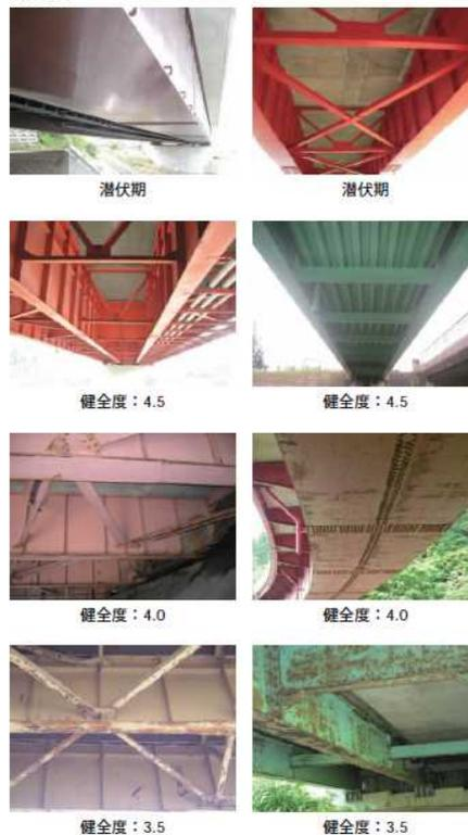
図5-6 健全度評価基準の例(点検ハンドブック)
