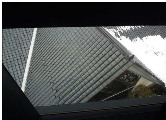
部位:屋根 屋上 仕様:勾配屋根(折板) 劣化状況:汚れている程度 特記事項:改修後10年以内
