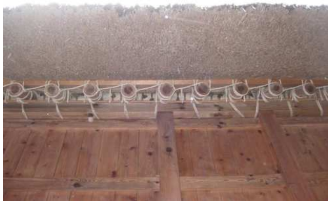
部位:屋根 屋上 仕様:茅葺き屋根 劣化状況:汚れている程度 特記事項:改修後10年以内
