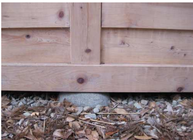
部位:外壁 仕様:土台下はごろた石 劣化状況:特になし 特記事項:背面にある土台はRC基礎に固定してある
