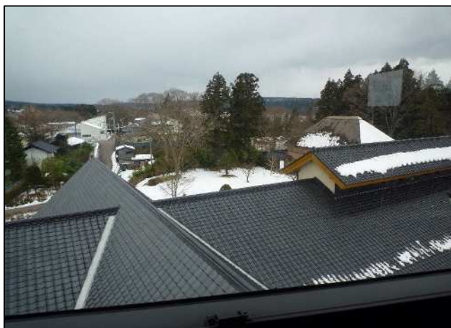
部位:屋根 屋上 仕様:勾配屋根(瓦類) 劣化状況:汚れている程度 特記事項:改修後10年以内
