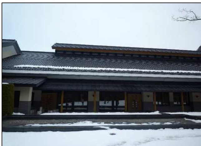
部位:屋根 屋上 仕様:勾配屋根(一部鋼板葺き) 劣化状況:汚れている程度 特記事項:改修後10年以内
