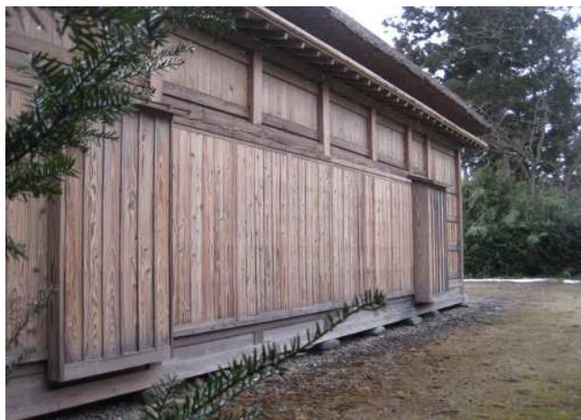
部位:外壁 仕様:杉板張り(相決り)、貫 赤松 劣化状況:特になし 特記事項:改修後10年以内
