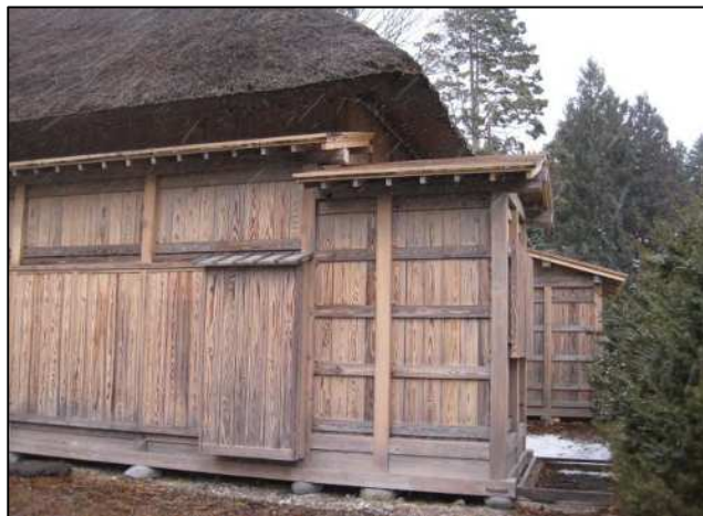
部位:屋根 屋上 仕様:茅葺き屋根 劣化状況:汚れている程度 特記事項:改修後10年以内
