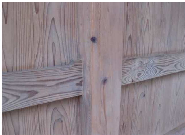
部位:外壁 仕様:貫構造 劣化状況:特になし 特記事項:貫構造により地震力を吸収する
