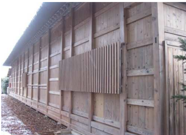
部位:外壁 仕様:杉板張り(相決り)、貫 赤松 劣化状況:特になし 特記事項:改修後10年以内
