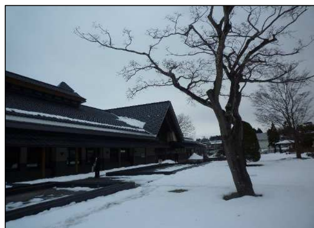
部位:屋根 屋上 仕様:勾配屋根(一部鋼板葺き) 劣化状況:汚れている程度 特記事項:改修後10年以内
