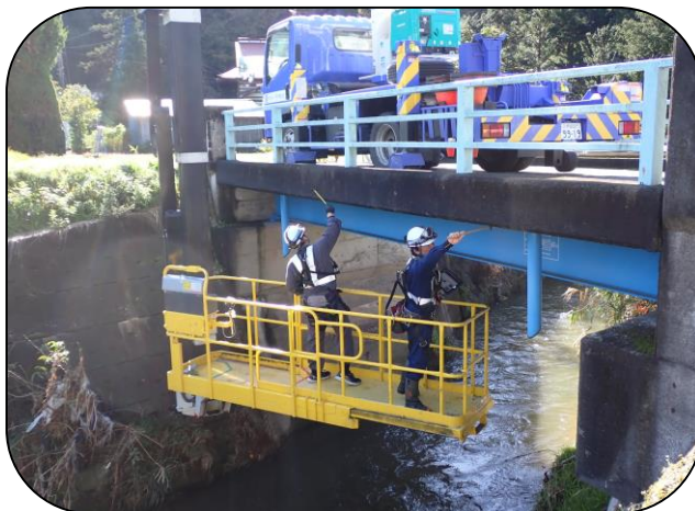
下荷軽井橋 点検状況 橋梁点検車による点検
