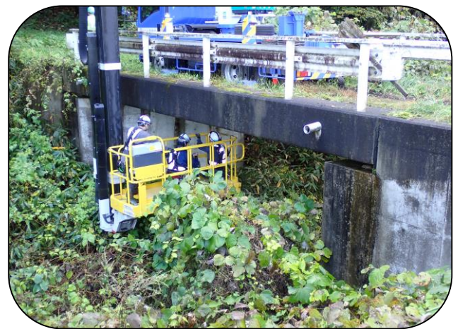
無名橋7 点検状況 橋梁点検車による点検
