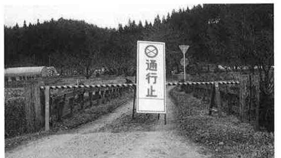
通行止になっている柵館橋
