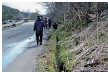
水路の泥上げ
