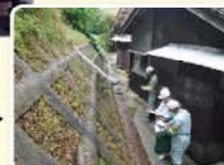
▶治山施設の点検
