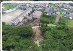
▲令和元年7月梅雨前線豪雨災害(山腹崩壊)により施設に被害(鹿児島県垂水市)
