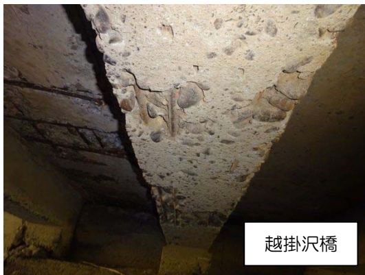
写真3 主桁の損傷
