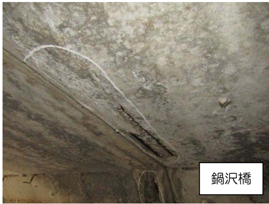
写真 7 床版の損傷
