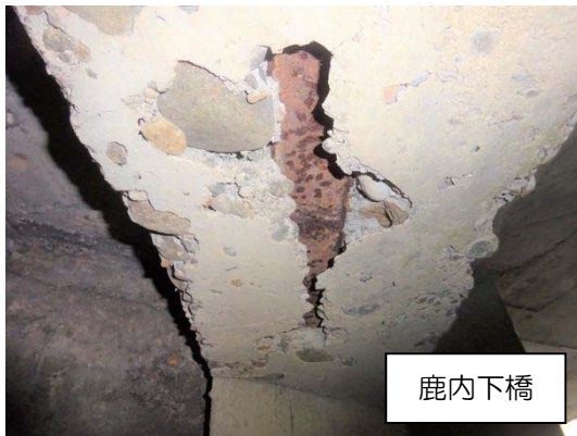
写真1 主桁の損傷
