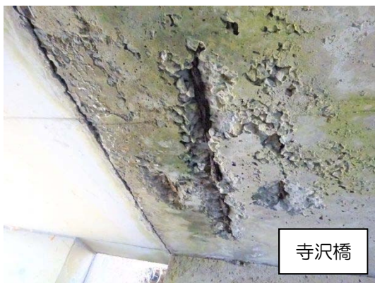
写真5 床版の損傷
