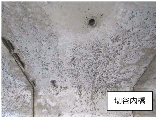
写真 9 床版の損傷
