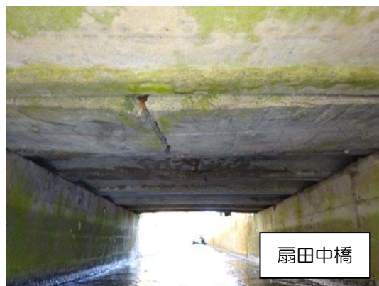
写真 12 主桁の損傷
