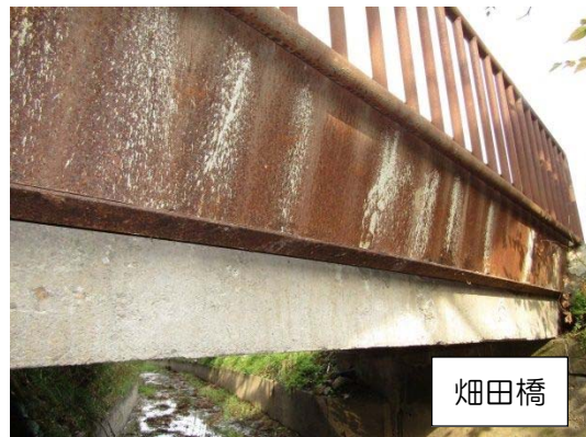
写真6 地覆の損傷
