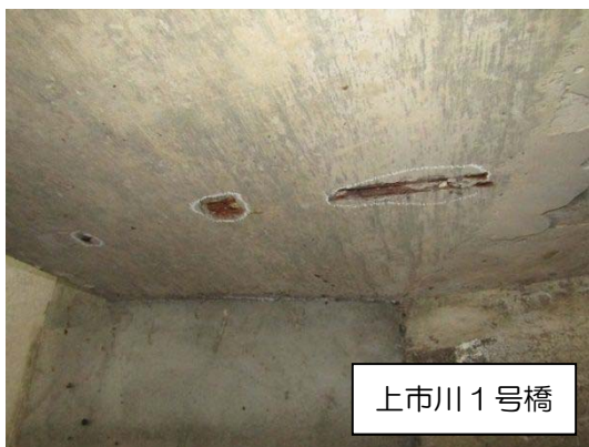
写真 11 床版の損傷
