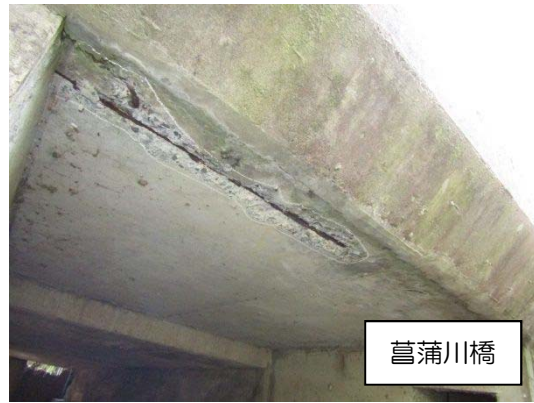
写真 8 床版の損傷
