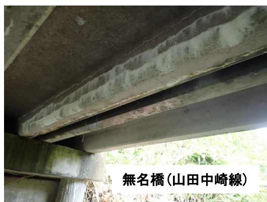
写真 3.4 アルカリ骨材反応の例
