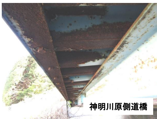
写真 3.1 防食機能の劣化・腐食の例
