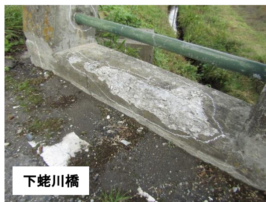
写真 3.2 凍害の例
