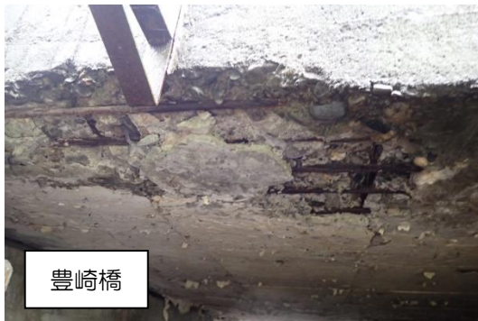
写真7 床版の損傷
