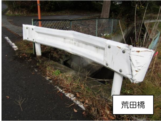
写真3 防護柵の損傷
