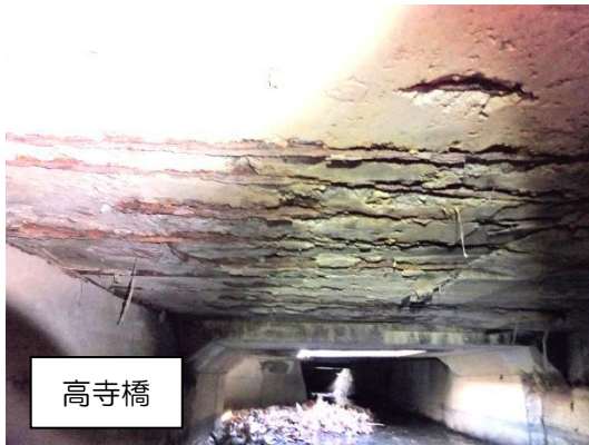
写真5 床版の損傷
