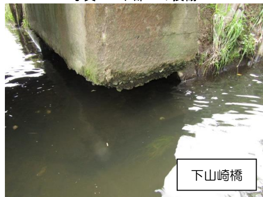
写真8 下部工の損傷
