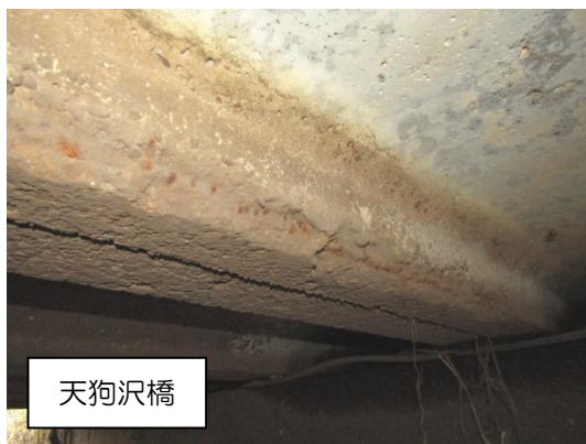
写真9 主桁の損傷
