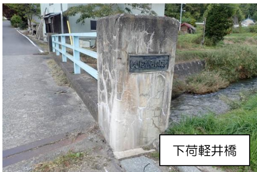
写真9 親柱の損傷
