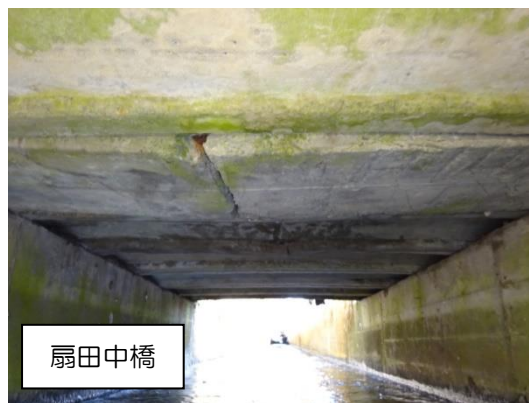
写真10 主桁の損傷
