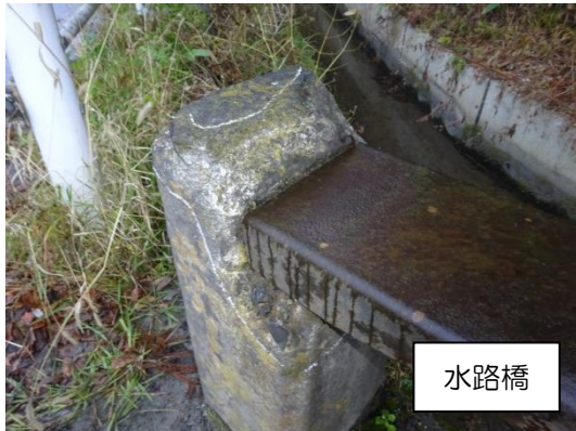
写真5 親柱の損傷
