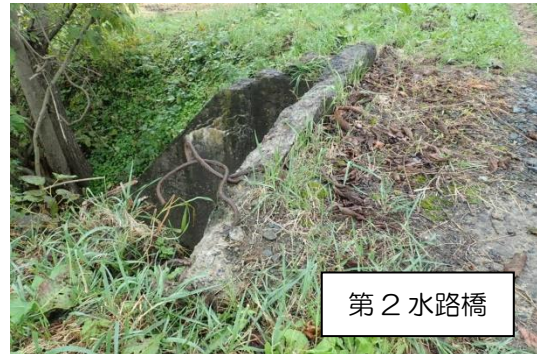
写真6 地覆の損傷
