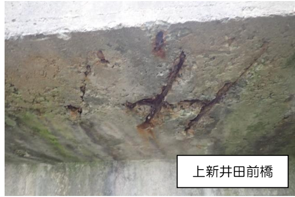
写真2 床版の損傷
