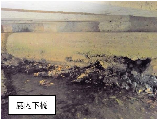
写真3 下部工の損傷
