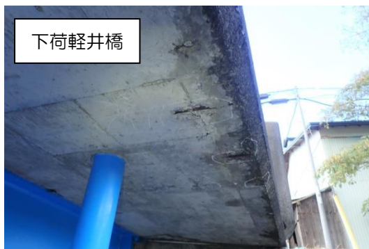
写真1 床版の損傷
