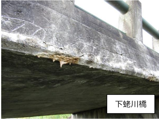
写真1 床版の損傷
