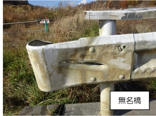
写真4 防護柵の損傷
