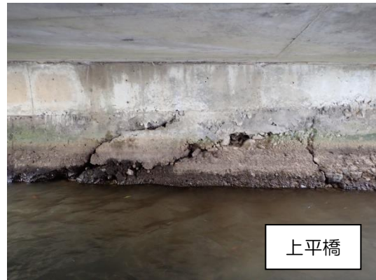
写真6 下部工の損傷
