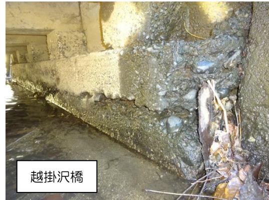
写真4 下部工の損傷
