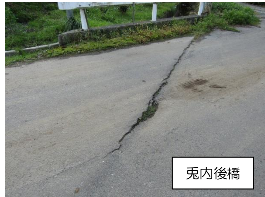
写真8 舗装の損傷
