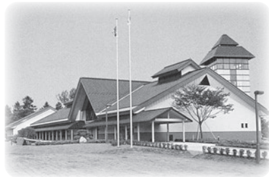
まちの駅建設予定地芝生広場
