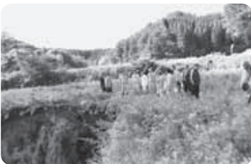
法面が崩壊された手倉橋水盛地区の水田
