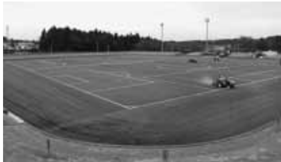
完成間近な人工芝生、ひばり野公園サッカー場
