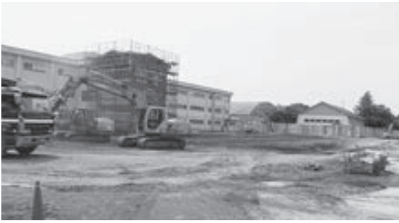
C棟が解体された五戸小学校
