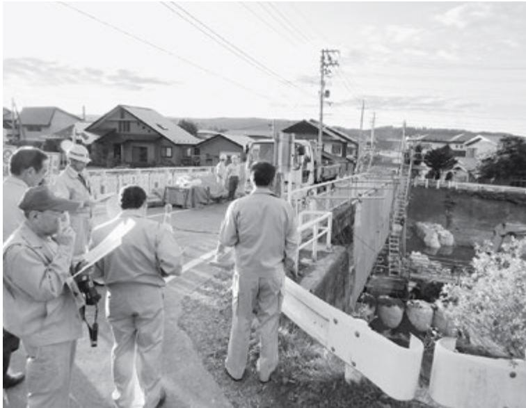
五戸橋の工事状況を確認
