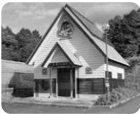
多目的トイレの設置が望まれる夢の森ハイランド駐車場のトイレ
