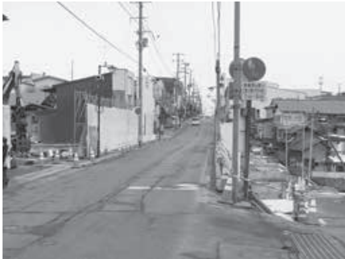
南側の住宅解体工事中 北側の住宅解体は終了
