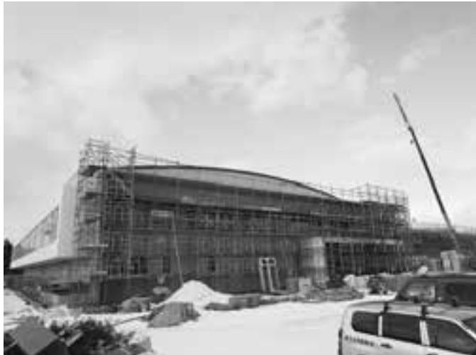
外観がほぼ完成した五戸小学校の体育館
