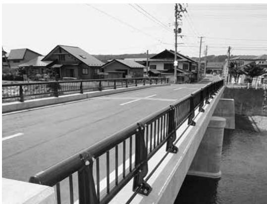
補修工事が完了した五戸橋
