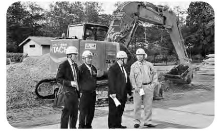
五戸消防署建設現場
