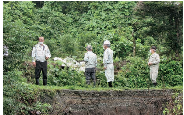
③ 横倉地区の道路の路肩崩落及び水路の土砂堆積現場 被災延長 L=10.0m 盛土・法面工、土砂撤去
