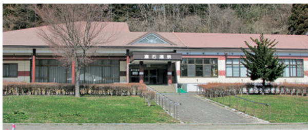
再開に向けて改修工事を実施する倉石温泉
