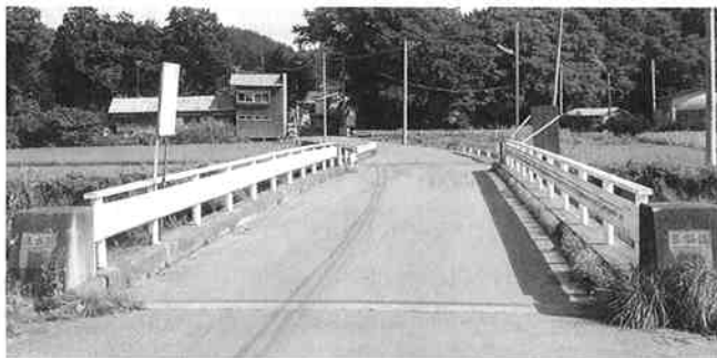
岩ノ脇地区への入口 岩ノ脇橋
