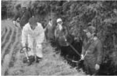
水路の清掃作業
