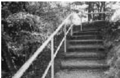
野沢城址公園の階段を整備
