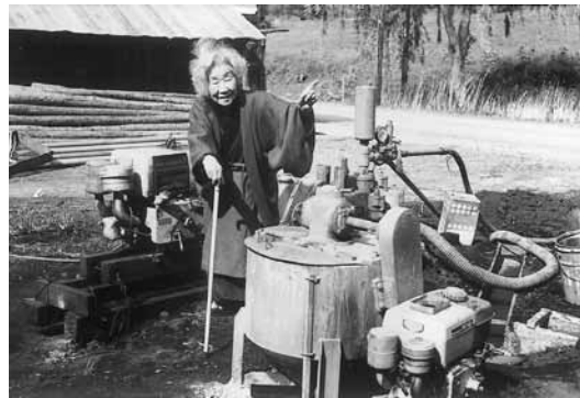
ボーリングをする現場と小笠原永子
