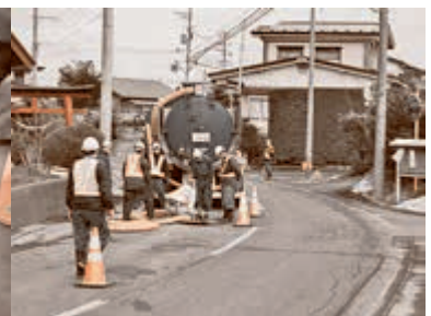
ゴミにより逆流した下水道管路の清掃状況
