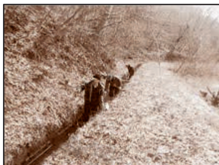
水路の泥上げ
