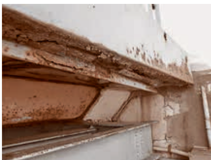
上部工鋼部材
