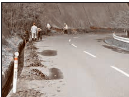
水路の泥上げ
