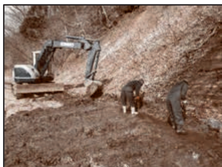
水路の泥上げ
